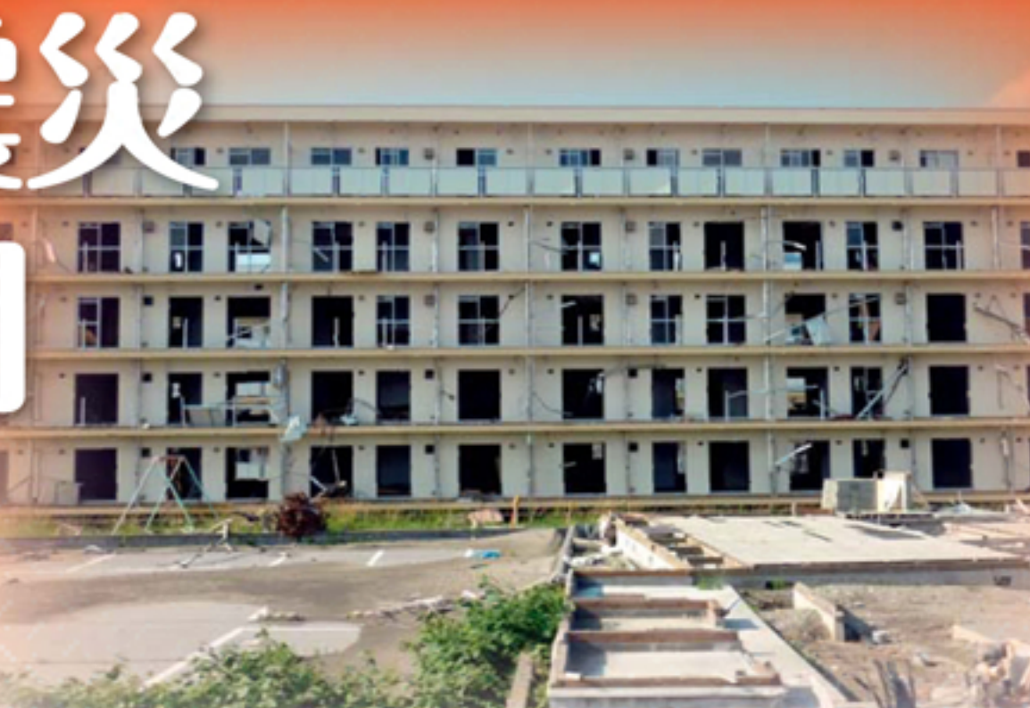
▲5F建ての建物 4Fまで津波がきています
